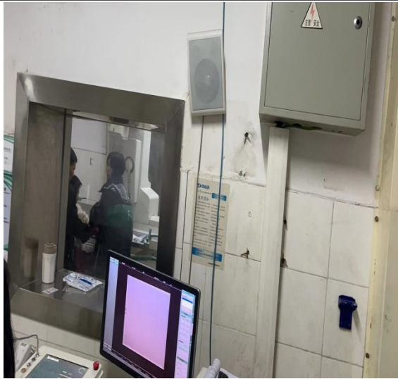
拟改造为介入手术室区域现状照片
