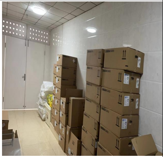
拟改造为介入手术室区域现状照片
