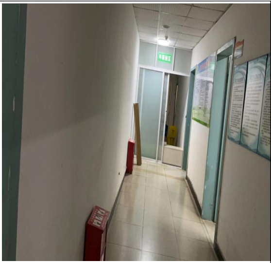
拟改造为介入手术室区域现状照片
